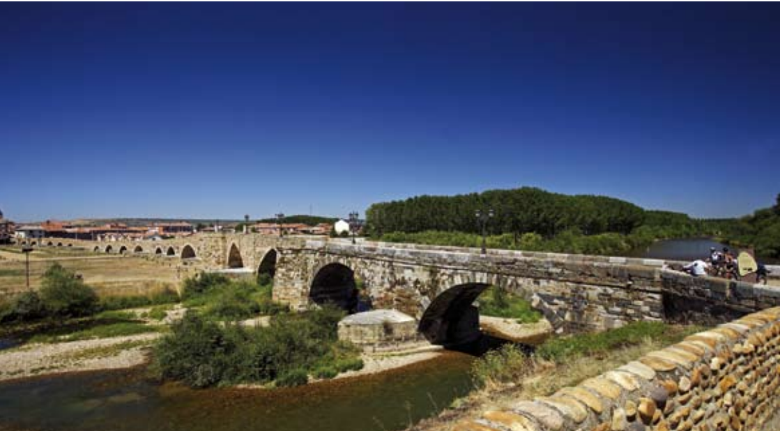
Puente. Hospital de Órbigo
