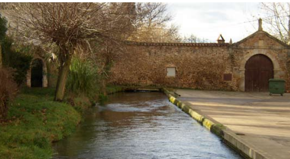
Presa forera a su paso por el Monasterio de Carrizo
